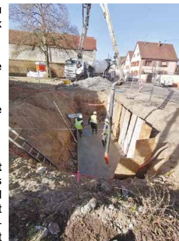
Pendant les travaux
