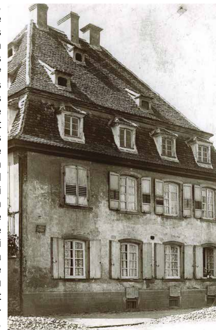
Maison Bardout, façade donnant sur la Grand Rue/archives privées
