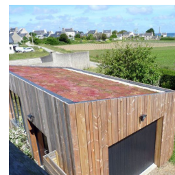
Toiture plantée sur annexe
