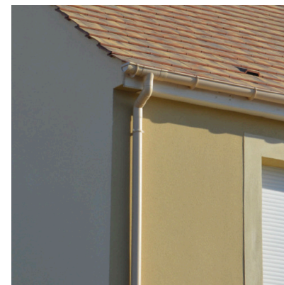
Gouttière en PVC beige comme la façade
