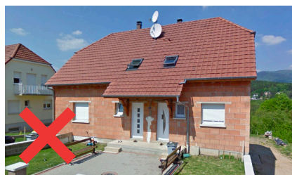
Utilisation à nu de parpaings
