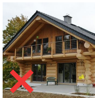
Utilisation de rondins de bois en façade
