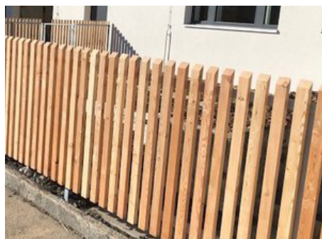
Poteaux situés à l'arrière de la clôture
