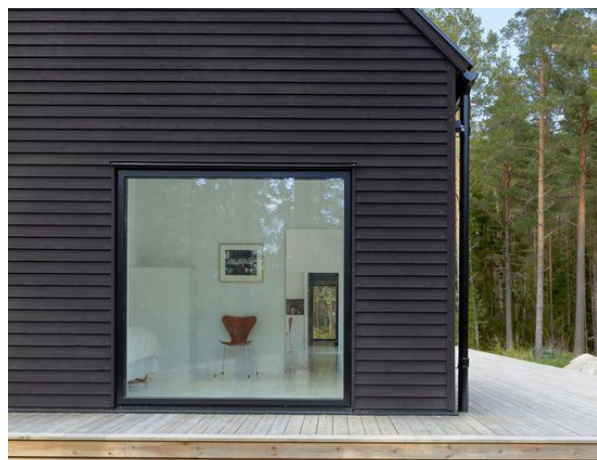
Gouttière et descente d'eau en accord avec la façade
