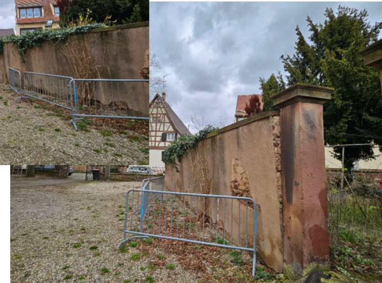
Dégradation du mur de clôture
